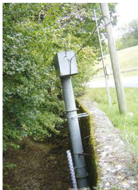
Vue de la station hydrométrique de Belbarras.
